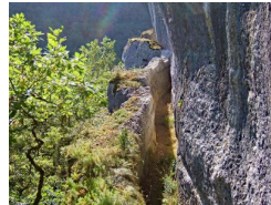
0.7km – Aqueduc romain de Divona
