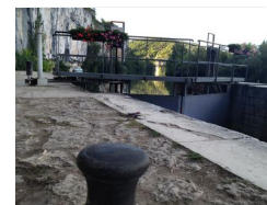
39.4km – Ecluse de Ganil
